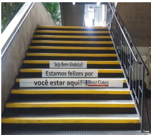
Pavimento térreo do prédio 1
